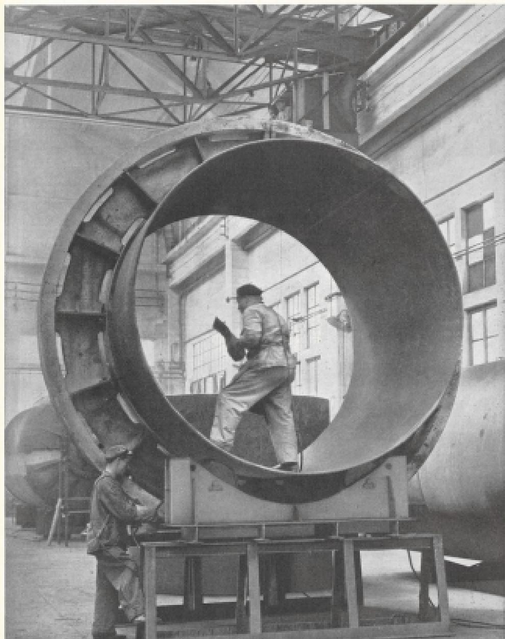
Gli operai Pietro Rossi (in alto) e Pietro Bellotti della Carpenteria montano sul banco una grande camera per l'assi di un motore costruito in lamiera, che sarà successivamente dotata. Questo tipo di motore in grande misura costruito in acciaio fuso.
